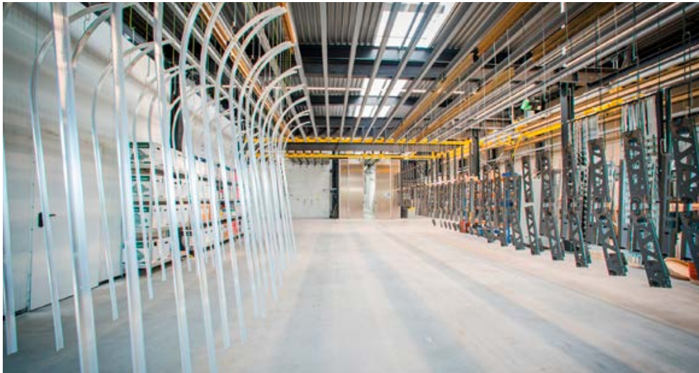
Der komplette Arbeitsbereich im Anschluss an den großzügigen Warenparkplatz ist bei Colour-Line auf nur 500 m² konzentriert.
